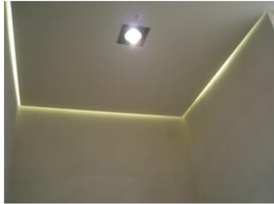
La construcción "en acción"
