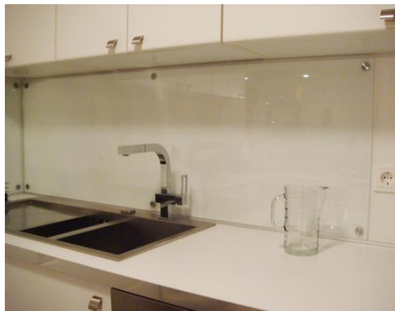
La protezione antispruzzo montata, ancora senza decorazione
