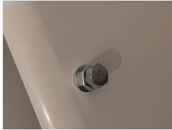
Die Schraube dient als praktischer Griff für die Revisionstür.
